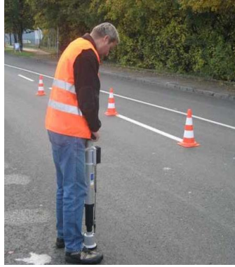
Fig. 2. Test de conductivitat per a avaluar la quantitat de CMA a la calçada.
